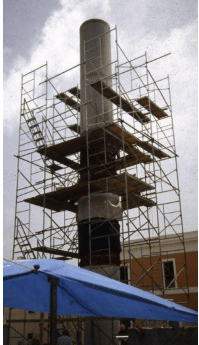
Tótem Telúrico en proceso de construcción, 1992. Archivo Jaime Suárez.
