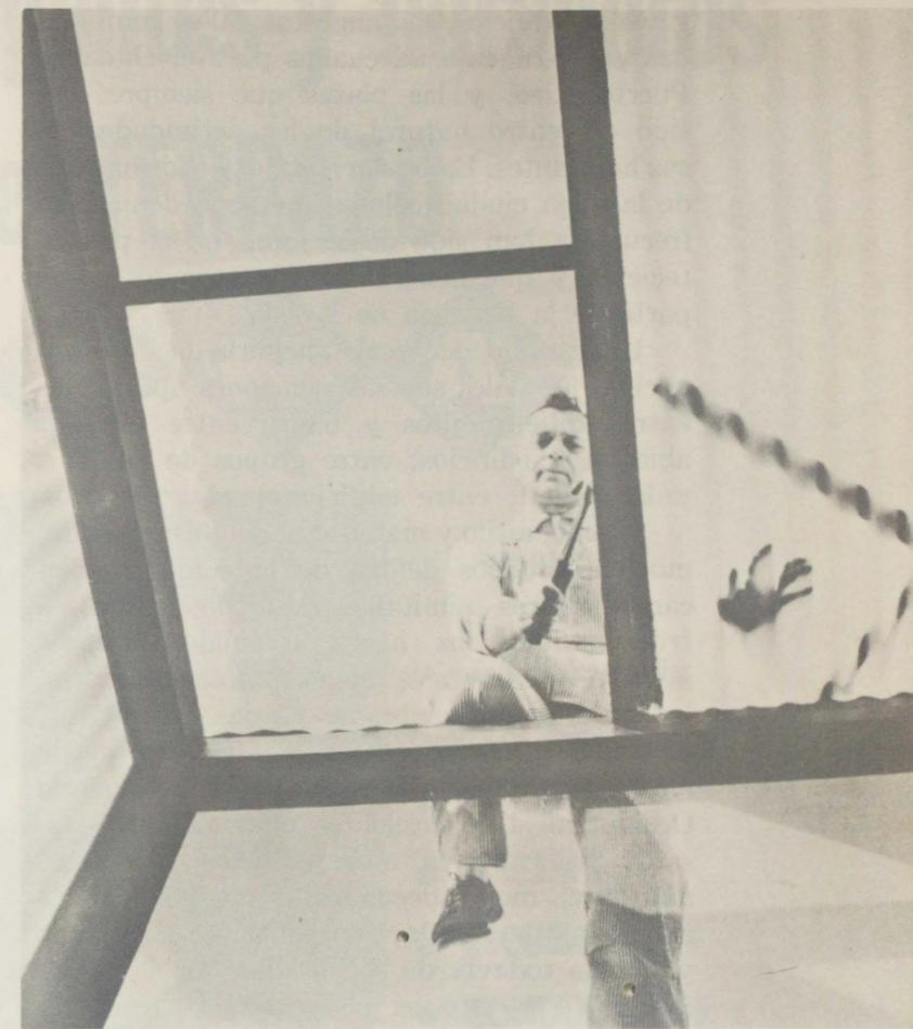
Son ya obtenibles para uso en edificios residenciales los nuevos paneles "Sunshade" de Fiberglas, hechos enteramente de resina acrílica "Lucita" de Du Pont y cuya construcción parecida a un emparedado consiste en una membrana reforzadora de fibras de vidrio encerrada entre dos membranas que forman la superficie.
