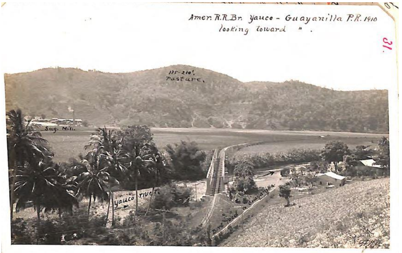
Puente del ferrocarril sobre el río de Yauco (1910)
