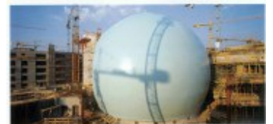
The balloon for the construction of the cinema's dome being inflated, August 1927 Ein Ballon für die Kuppelarbeit aufgeblasen. August 1927
